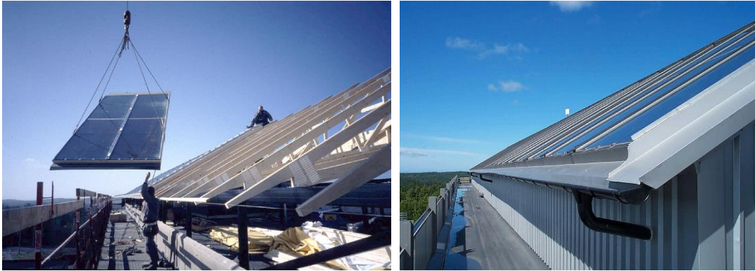
Figur 38. Montage av solfångarelement direkt på takstolarna i Gårdsten
