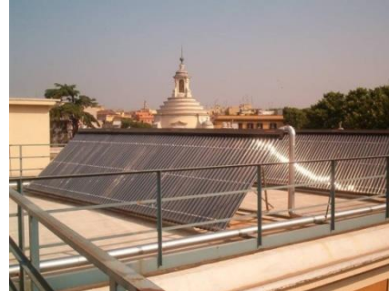
Figur 29. Installation med vakuumsolfångare. Foto: Thermomax/ ESTIF
